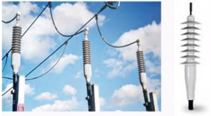
شکل ۴-۱۰ سرکابل فشاری ولتاژ بالا
